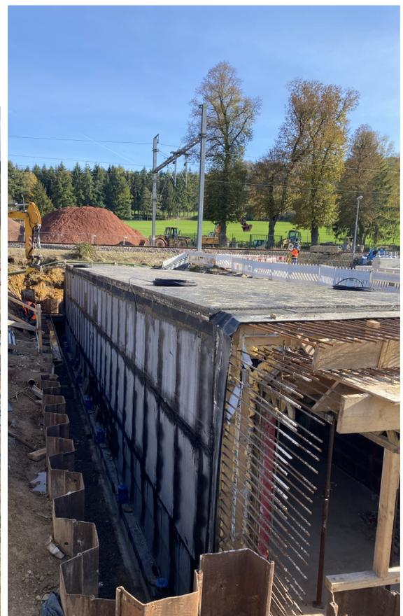
**Bauphase: Einschub Rahmenteil unter die 3-gleisige Bahnanlage**
